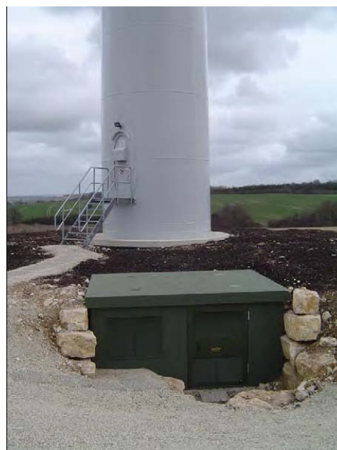
Figure 29 : Principe de l'insertion d'un poste de transformation
