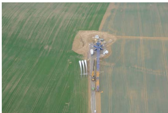
Figure 11 : Photos des emprises vis-à-vis des zones cultivées pendant les travaux (Source : Maïa Eolis)
